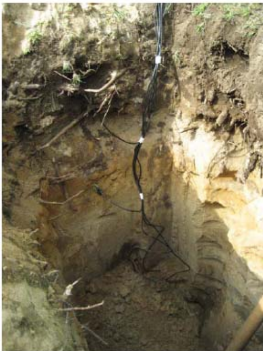
Sensores instalados en el punto del cortafuegos (Marismillas cota baja).
