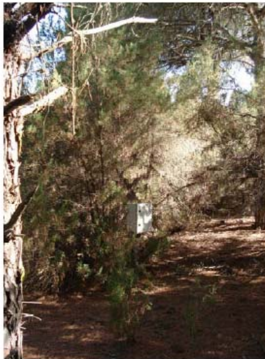
Caja protectora de los data-logger , situación tras instalación de los sensores. (Marismillas cota media).
