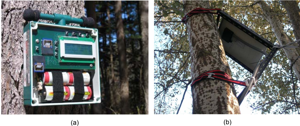
Fig.1. a) SongMeter (Wildlife Acoustics, Inc.) como estación de seguimiento. b) Empleo de placas solares para recargar las baterías externas v aumentar así la autonomía de la estación.
